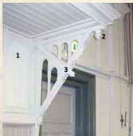
◀ Detaillering van de afdakjes boven de banken in de kerk in Koudekerk (J.J. de Graauw).
